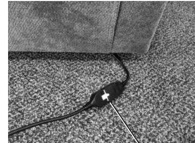
Conexión del transformador de energía
