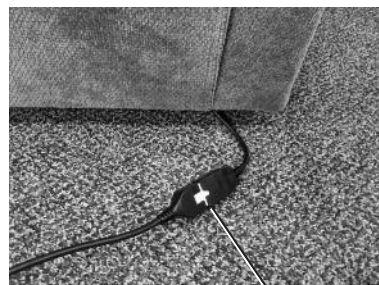
Connexion du transformateur
